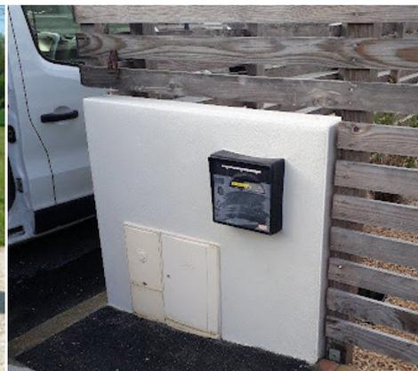
Les coffrets de branchement peuvent faire partie des éléments techniques à intégrer pour assurer la qualité des espaces publics. Ils peuvent être intégrés dans des plantations, dans un habillage bois ou dans un élément maçonné. Quelque soit le principe d'intégration retenu, les coffrets devront rester accessibles depuis l'espace public.
